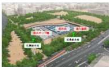
泉尾配水場（平成 25 年度完成）
